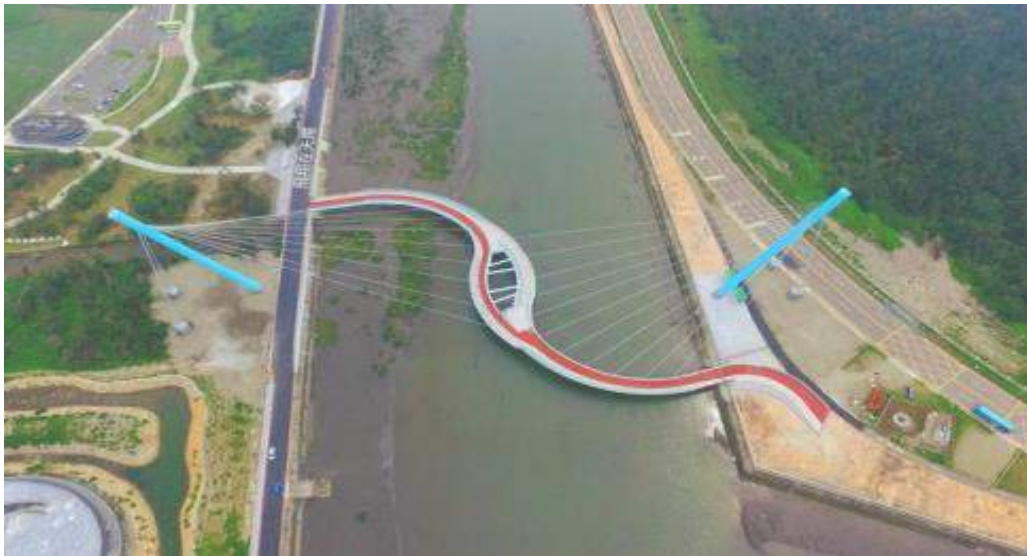
圖 2-4 景觀橋暨海堤路景觀美化改善工程
