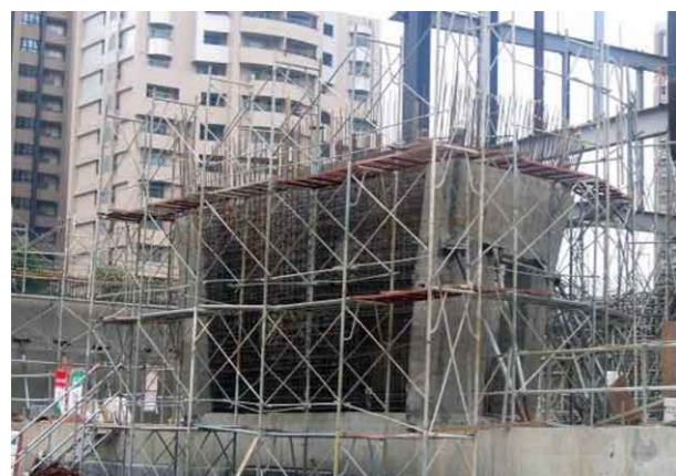
100年12月起，曲牆結構系統一階下部曲牆實體工程陸續完工
