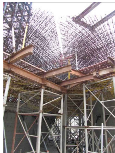
101年2月，一樓曲牆頂板結構閉合搭設
