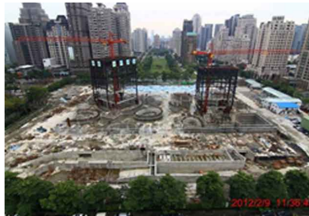
現場施工概況
