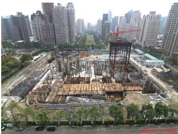
現場施工概況
