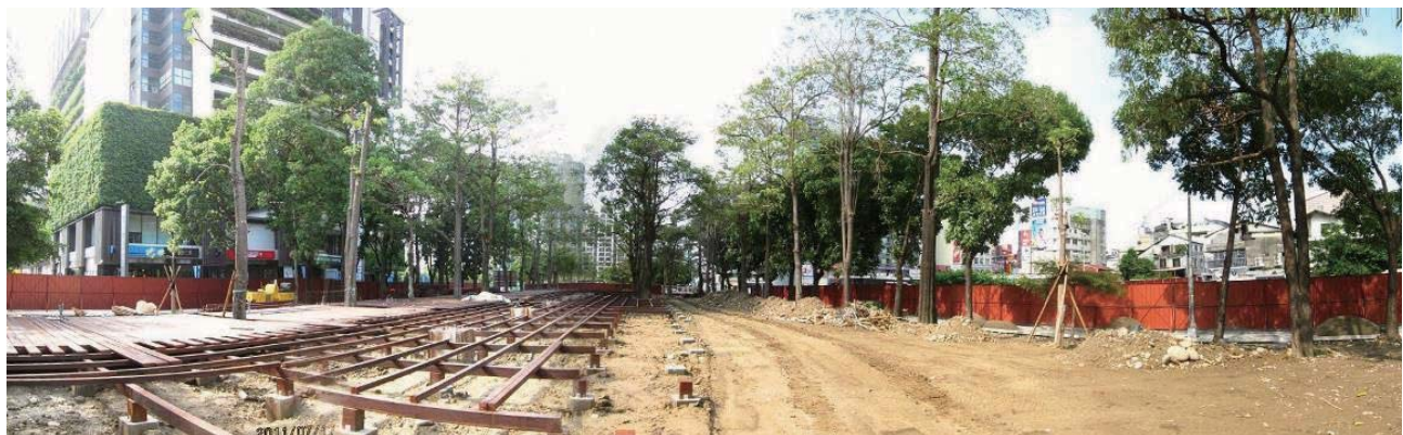
「英才路470巷至公益路」工區之木作工程現況圖
