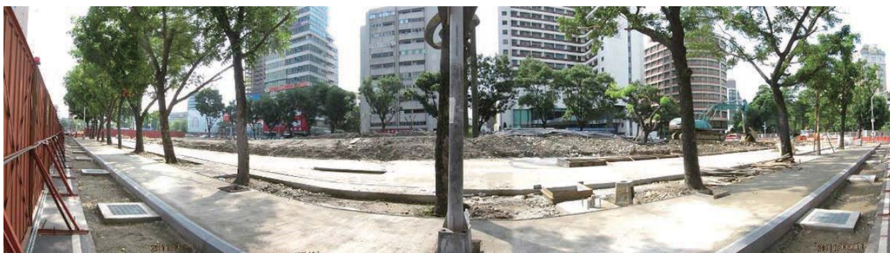
⤴ 「中港路至英才路470巷」工區現況圖
