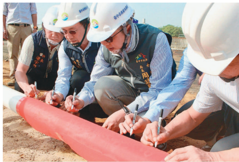
台中花博外埔園區自然館已完成上梁，預計明年5月完工。
