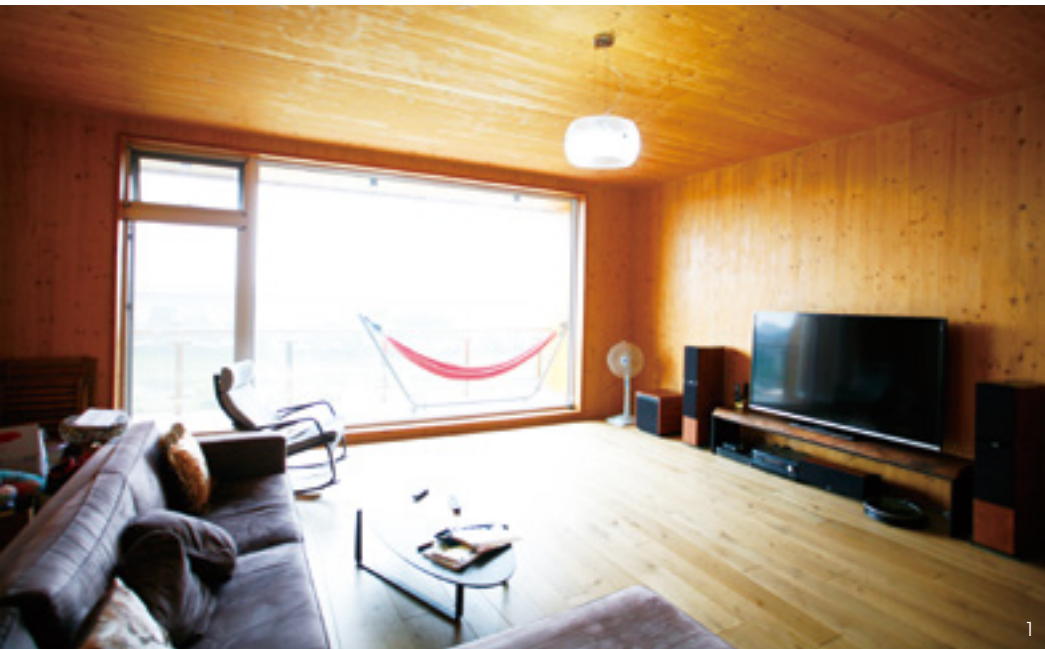
1. 內外牆與結構合而為一，不須再次施作室內裝修，以直覺的建築構造行為，形成骨肉合一。2. 構造設計讓剖面高度利用度達到最佳，平面規畫時也可讓牆面的延續性完整。
