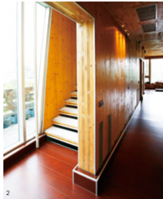
1. 內外牆與結構合而為一，不須再次施作室內裝修，以直覺的建築構造行為，形成骨肉合一。2. 構造設計讓剖面高度利用度達到最佳，平面規畫時也可讓牆面的延續性完整。
