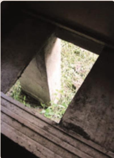
部分地板塌陷、變軟，甚至有破洞；下面基樁有的被白蟻蛀蝕或受潮，必須鑽到地板下方逐一檢查，重做基柱補強。原有的地板經重新打磨後，繼續使用。
