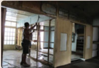
有些梁柱被白蟻蛀蝕，隨時有脆化斷裂的危機，必須先做基柱補強，甚至整根抽換，盡量使用舊木頭。確認房子結構後，將不必要的夾板隔間拆除，讓空氣、陽光進來。
