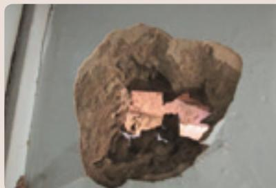
剝落嚴重，甚至露出裡頭的編竹夾泥牆。木製櫃子多有蟲蛀、腐壞的狀況。破損壁面重新粉漿，櫃子則補鋪木板。
