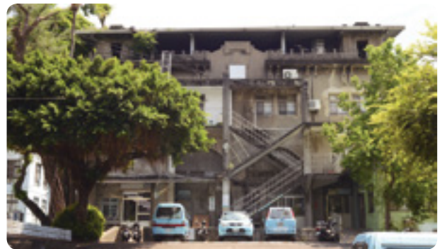
三層樓高的上水塔完工於1916年，立面有簡化的西方古典風格裝飾。
