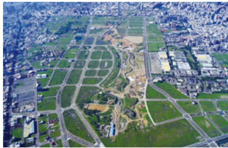
原為台中水湳機場的水湳智慧城，占地 254 公頃，未來將整合經貿、創研、大學、休閒、文化、生活等機能，成為智慧、低碳、創新的智慧城示範區。圖為開發中的預定地。
