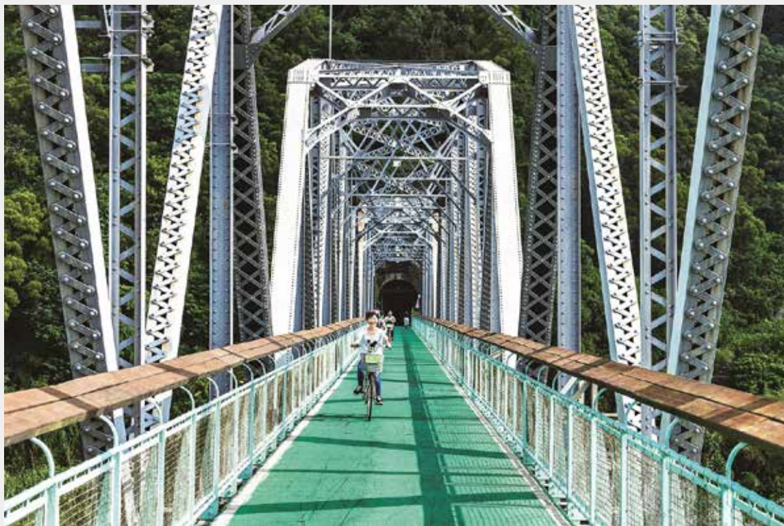
后豐鐵馬道-花梁鋼橋
