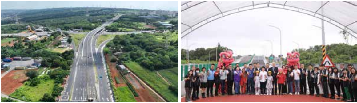
1 2 1.2.中科西南向聯外道路完工通車。
