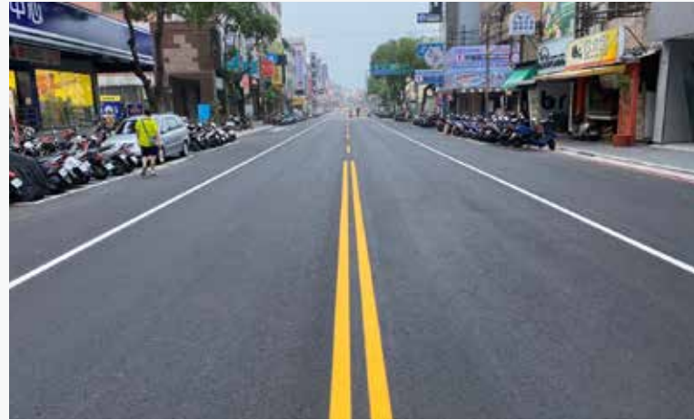
黎明路全段燙平完成
