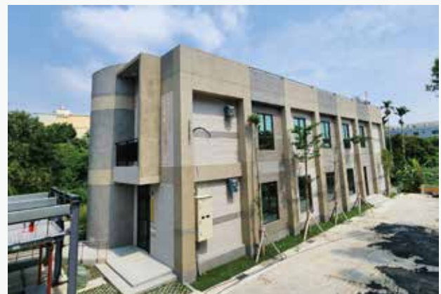
龍井區龍泉里活動中心已完工啟用
