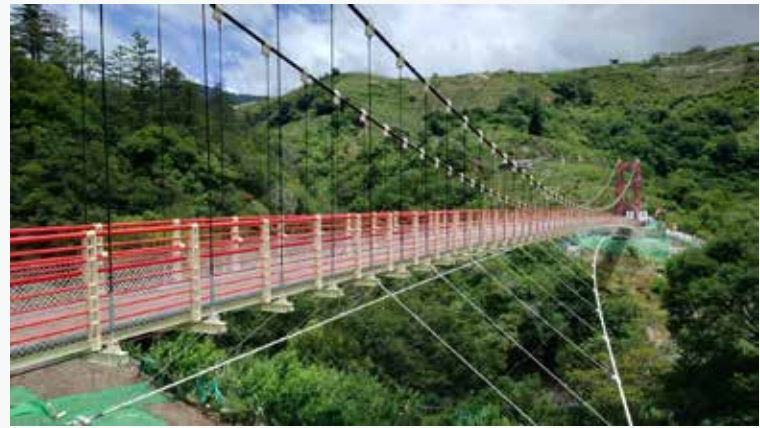
和平區環山部落南湖溪新建吊橋
