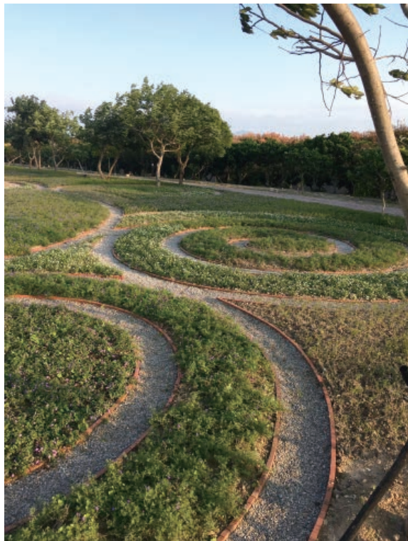
上 后里環保公園造景工程，營造排水、保水與透氣的環境。
