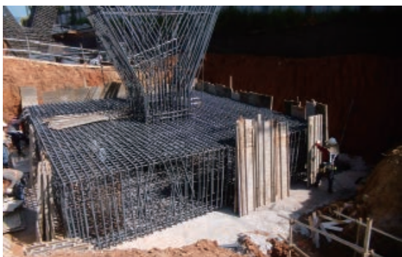
花馬道工程目前主要辦理橋梁橋墩基礎作業。
