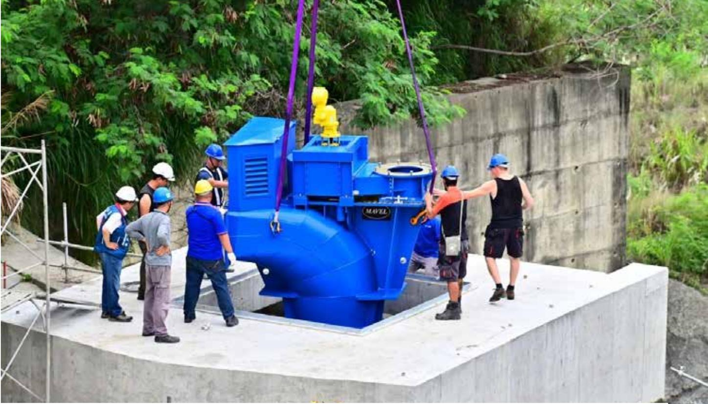
本府並同時推動「臺中市小水力發電開發計畫」，首座案場選定於市管區域排水食水料溪出口設置小水力發電機組，利用虹吸原理將水流位能帶動水輪機轉換為電力，同時透過石岡水資源回收中心廠內低壓電力併聯連
