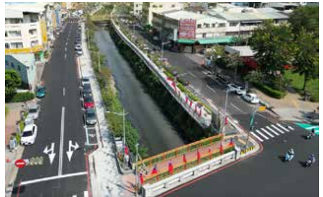
梅川周邊人行道改善工程第一期已完工
