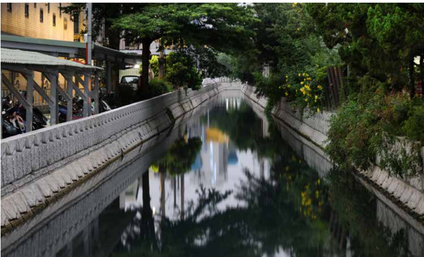
中興大排(大衛路至國光路)護岸改善治理工程完工
