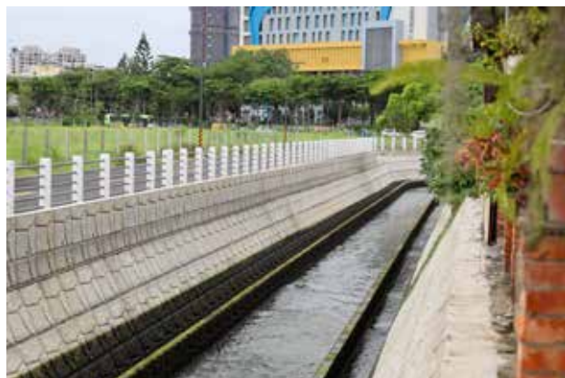
中興大排(大衛路至國光路)護岸改善後可有效改善附近淹水問題
