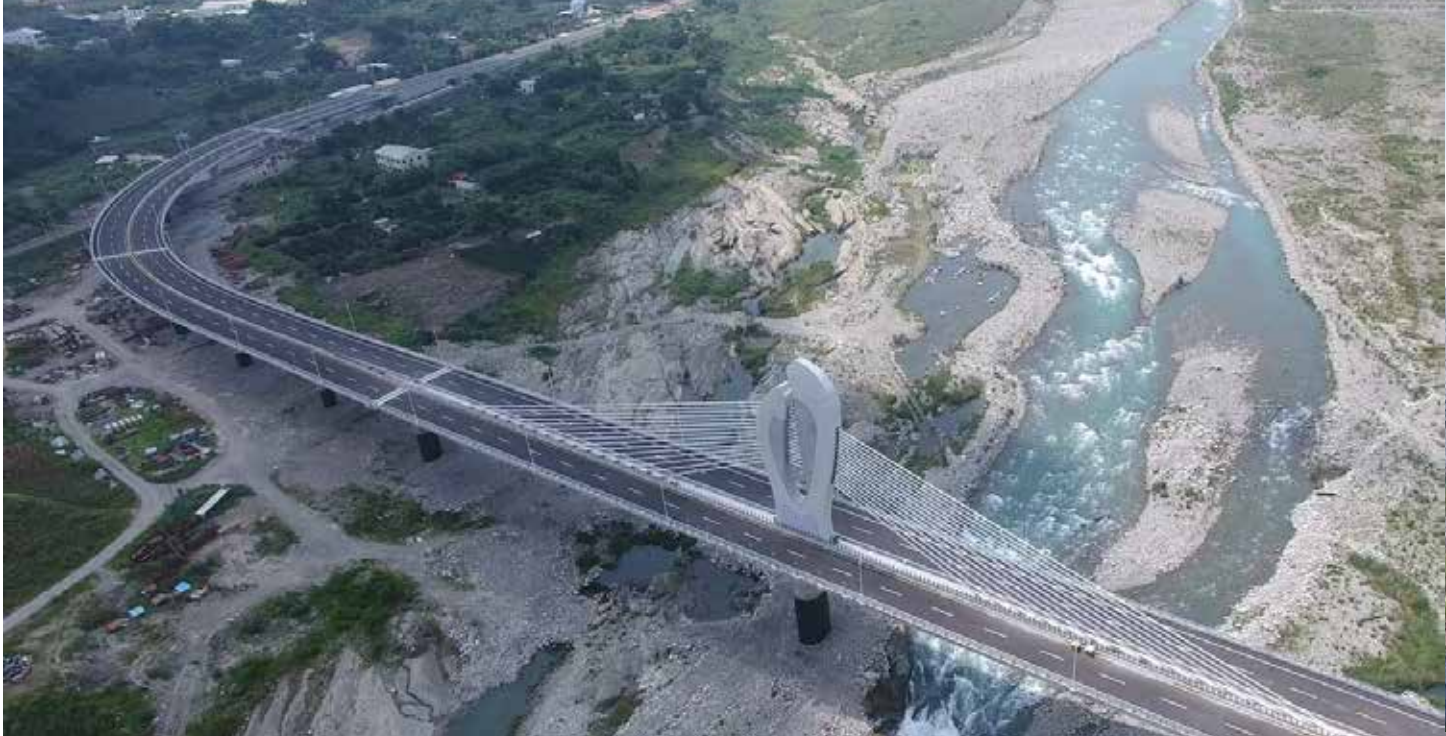
東豐快速道路工程完工模擬圖
