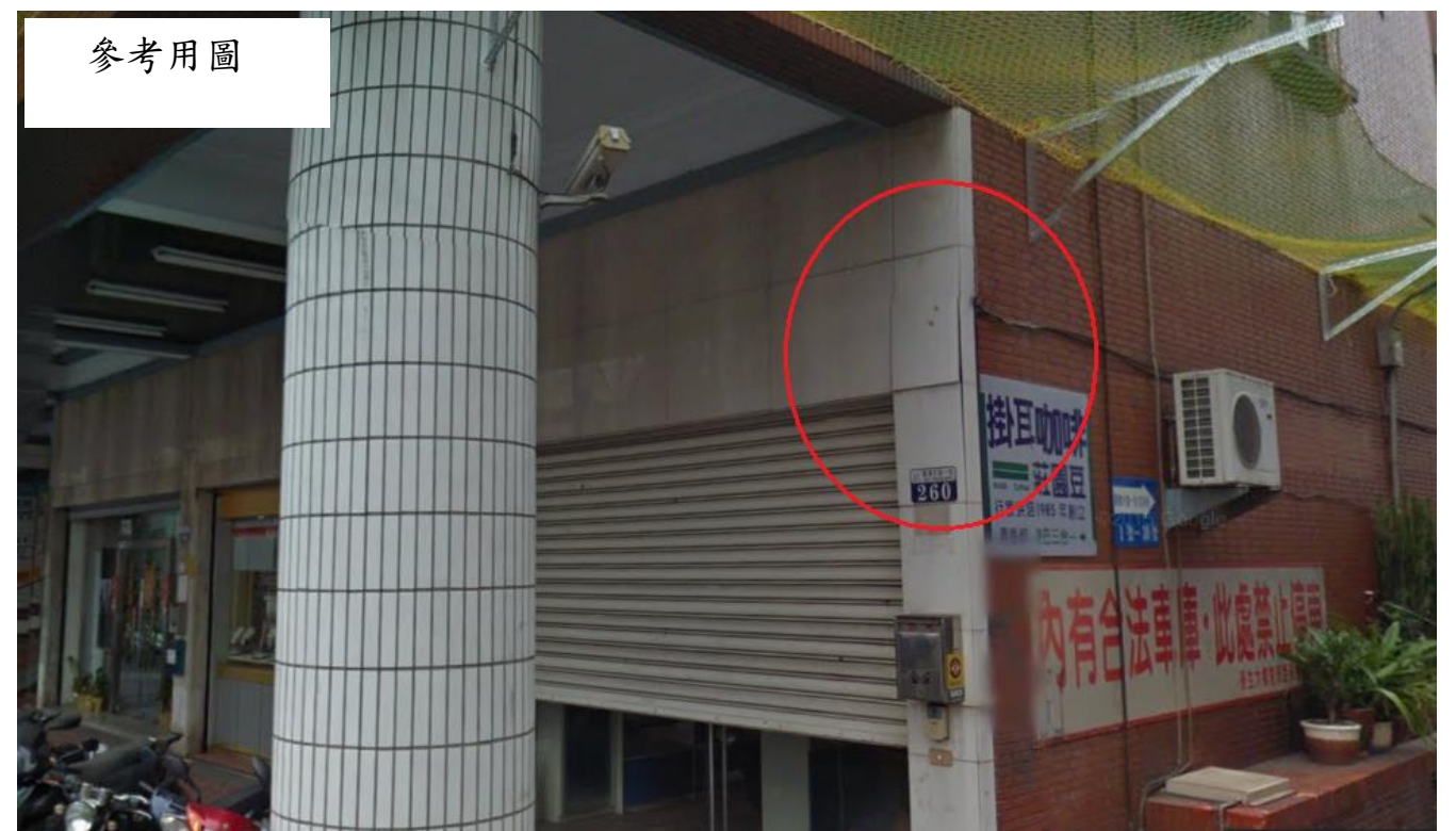
一樓大塊磁磚已損壞多處須更新
