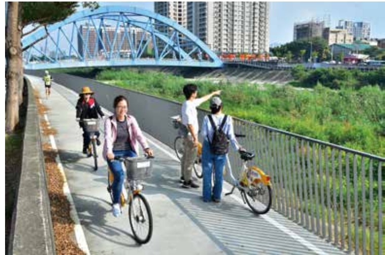
旱溪西路自行車道建置工程完工
