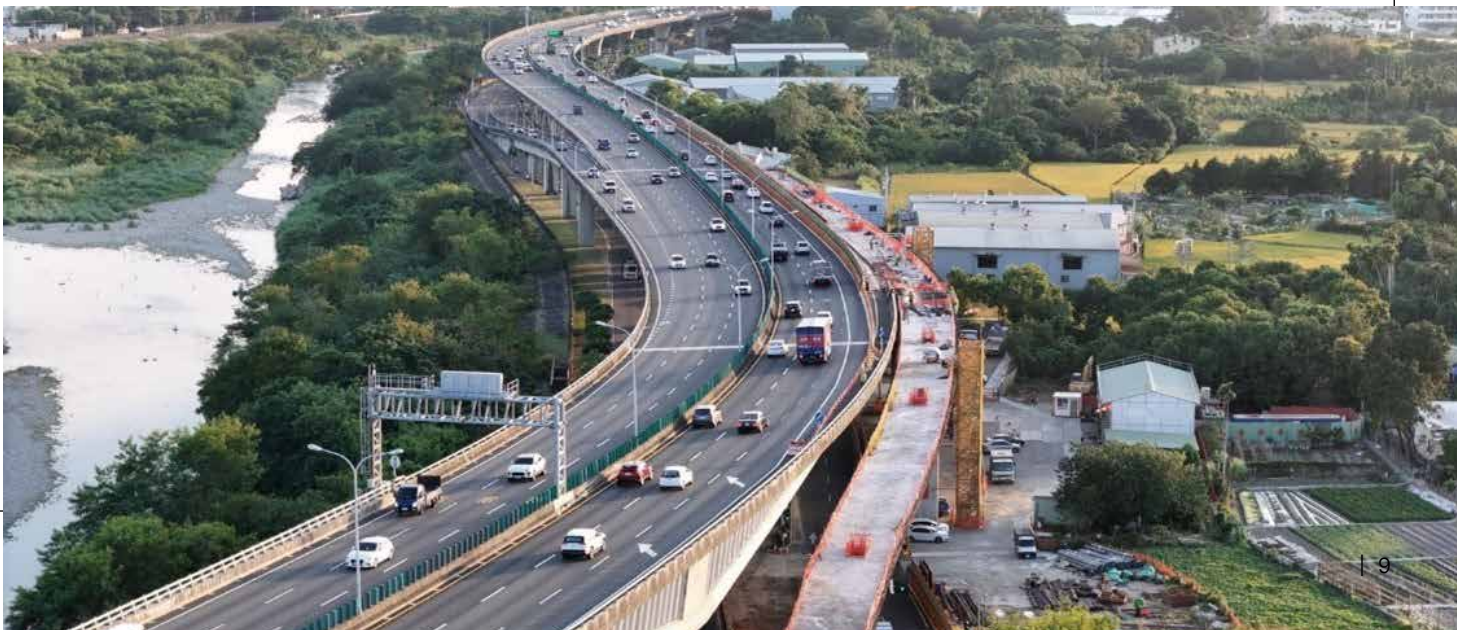
六順橋南入匝道施工進行中
