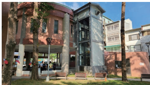
西屯何仁里活動中心後方增設電梯
