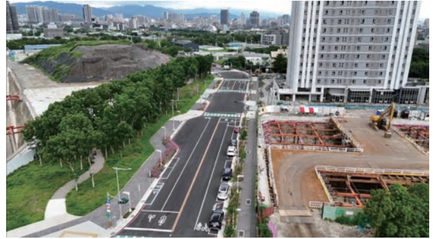
北屯崇德十九路延伸工程完工通車
