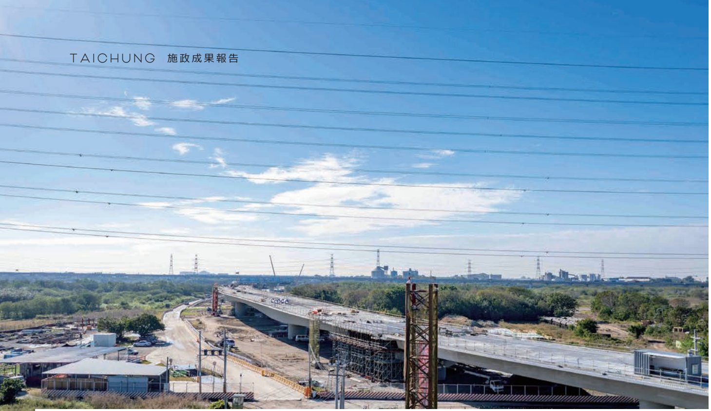
大肚和美跨河橋梁預計115年完工
