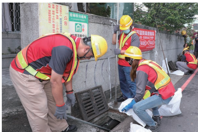
清理雨水下水道與側溝預防鼠患
