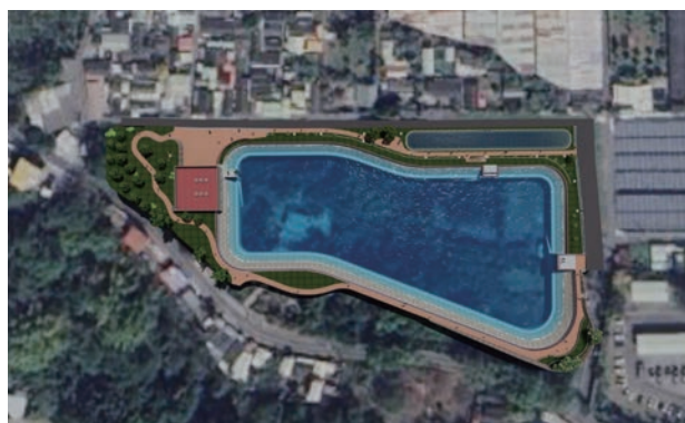
白冷圳第2期中興嶺調整池新建工程現正施工，將有助新社地區擴大灌溉系統
