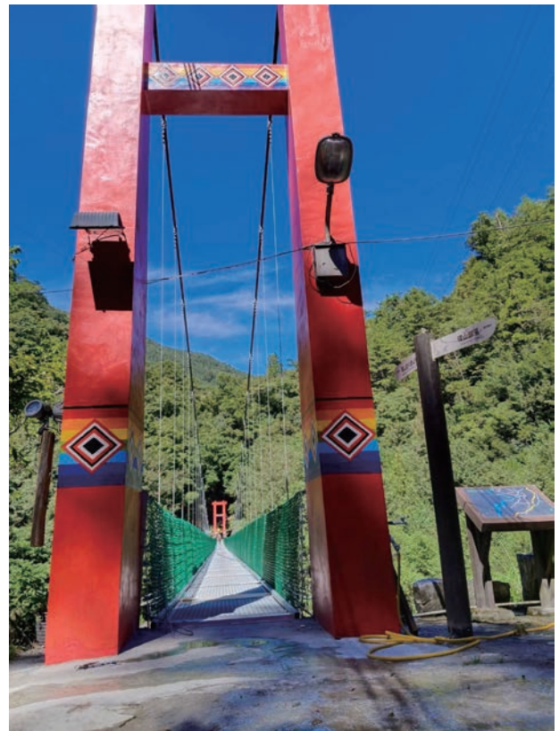
環山1號吊橋已於114年10月完工
