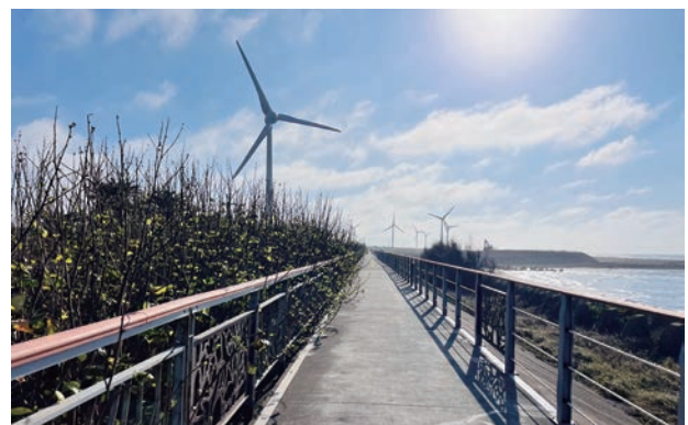
濱海自行車道選用耐候性較佳的材料強化整體欄杆結構安全
