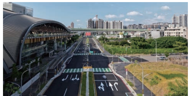
東光路完工後將增進松竹車站與周邊區域發展
