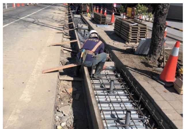
市府自籌經費為豐勢路二段新增排水設施
