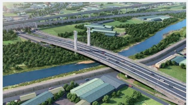
市政路延伸工程第一期已順利完工通車
