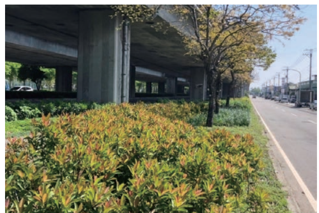
綠指環計畫與企業合作於臺74沿線高架橋下創造帶狀綠廊
