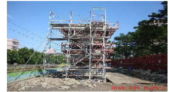
圖8-4 太原站墩柱施作
