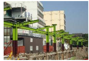
圖8-3 月臺延伸工程
