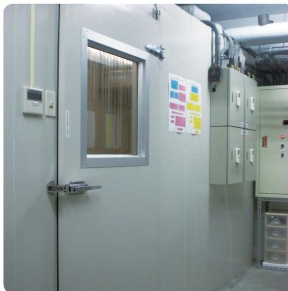
冷藏室之室內外地板一路到底、一體成形之規劃，可使用推車直接入庫上架，除大幅降低疫苗在室外等待上架時間外，如遇冷儲異常事件急需撤出疫苗，亦可於最短時間完成。
