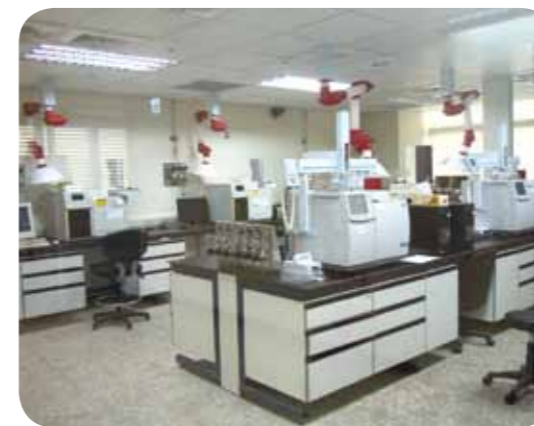
圖 5-16 「衛生局實驗室重建及搬遷工程計畫」完工之實驗室。
