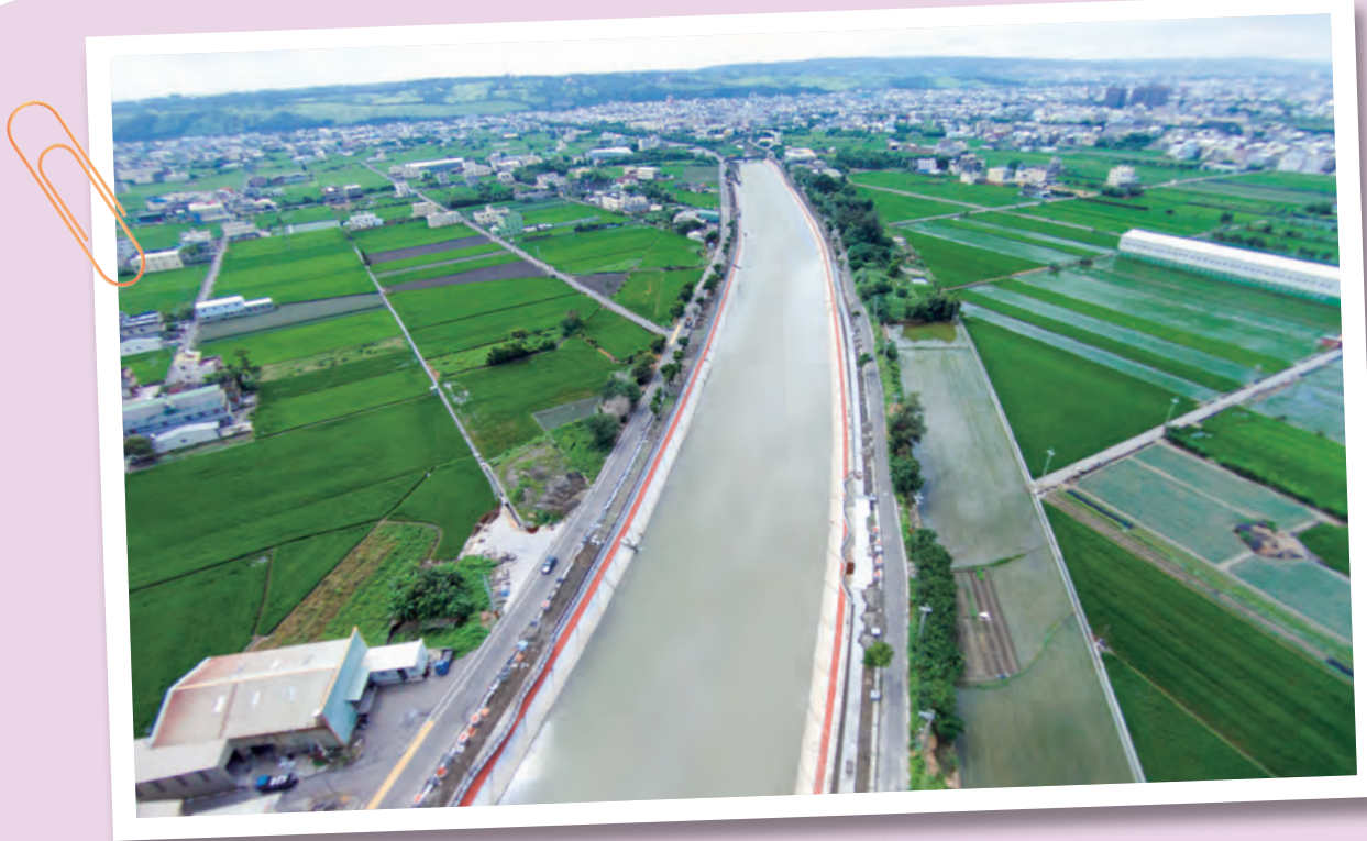
▲ 清水大排整治兩側護岸，提升河道防洪力。
