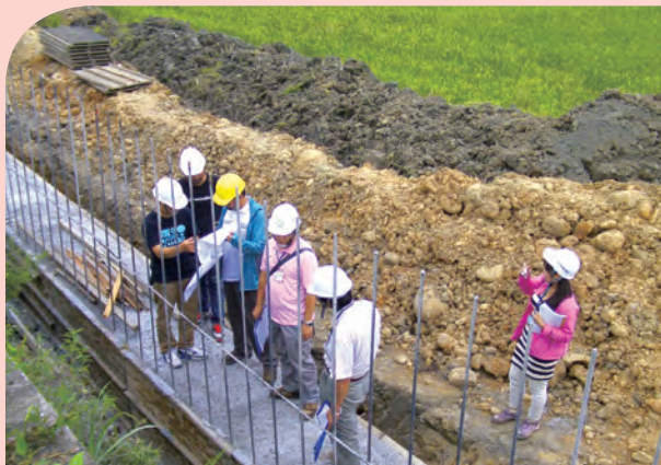
▲ 外埔區馬鳴里新厝路農路拓寬工程督導。
