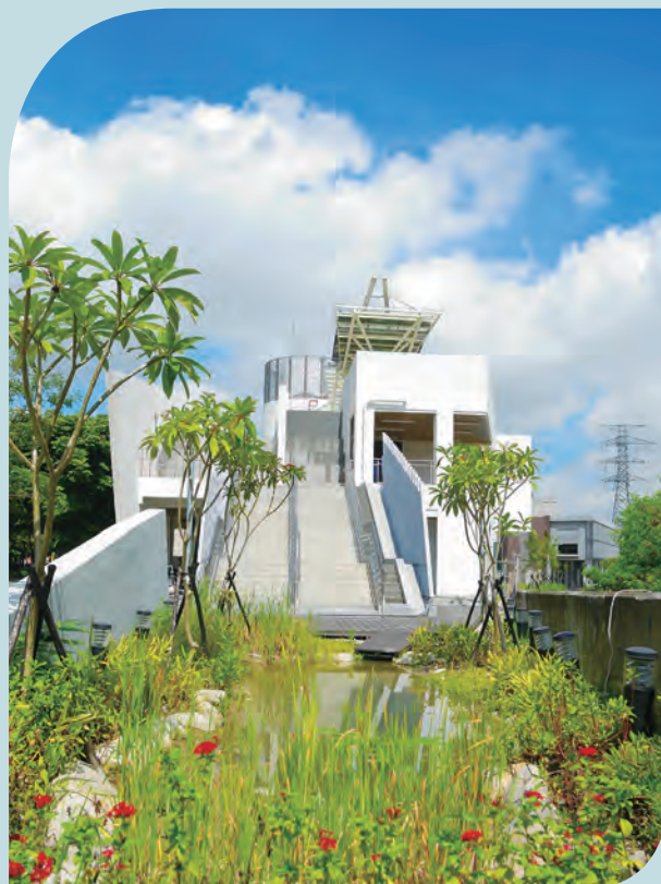
▲ 廊子水資源回收中心前還有一座植滿花草的生態池。
