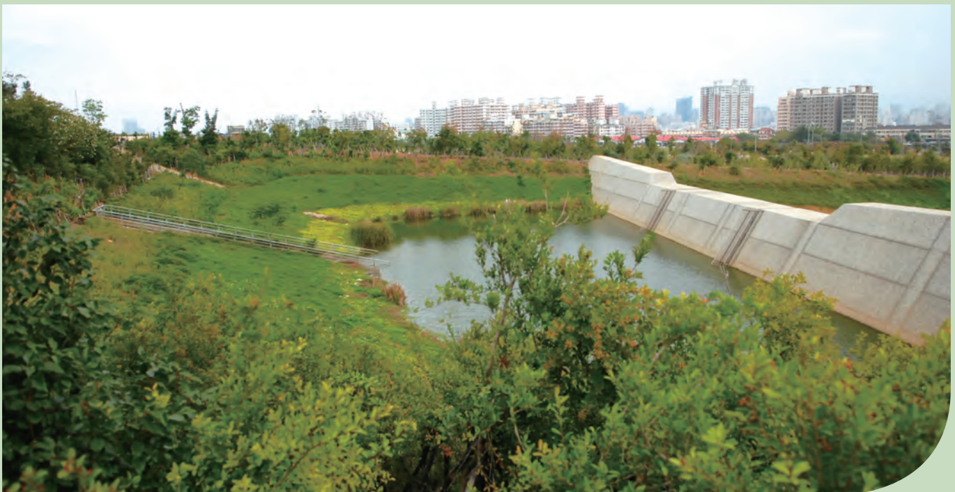
▲精密機械科技創新園區設置滯洪沉砂設施,並透過完善的排水規劃,讓土地永續利用。
