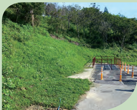
▲ 坡地開發進行植生及沉砂設施，加強水土保持。
