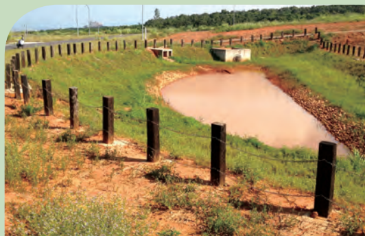
▲ 開發者依據水土保持計畫書設置滯洪沉砂設施。
