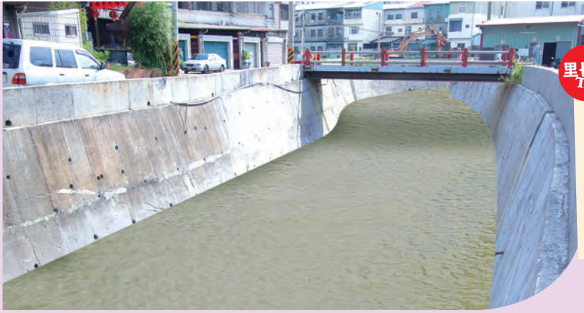
▲ 東村橋下游護岸拓寬2公尺及新建擋土牆85公分。
