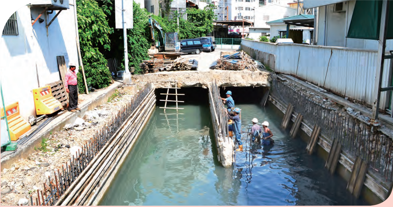
▲ 沙鹿區中山路、大同街附近的竹林南溪改善排水箱涵，增大通洪斷面。
