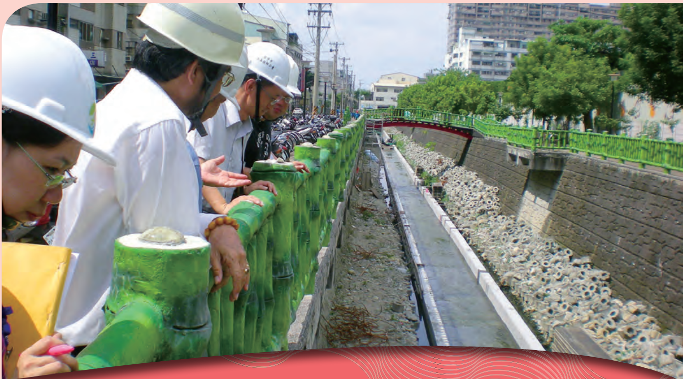
▼ 北屯圳(東光一街)下游環境改善工程。
