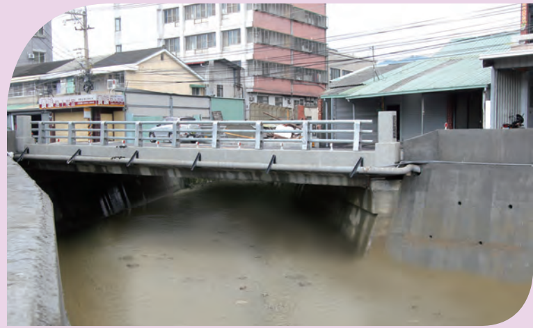
▲ 東村橋將梁底抬高50公分，增加通洪斷面。
