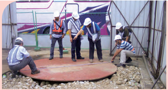
▲ 中區污水下水道分支管網工程工地安全督導。
