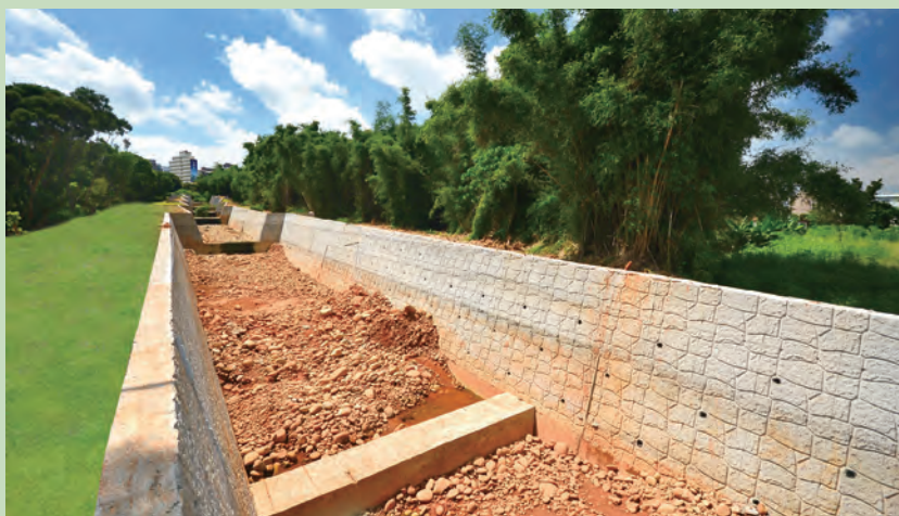
▲ 北勢溪(六福巷至北勢東路)建置穩固的固床工護岸。
