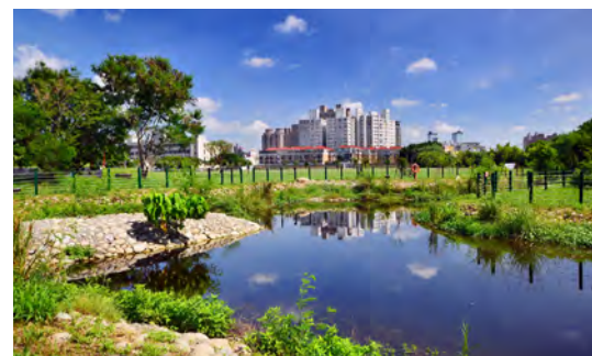
▲ 福田水資源回收中心生態池
