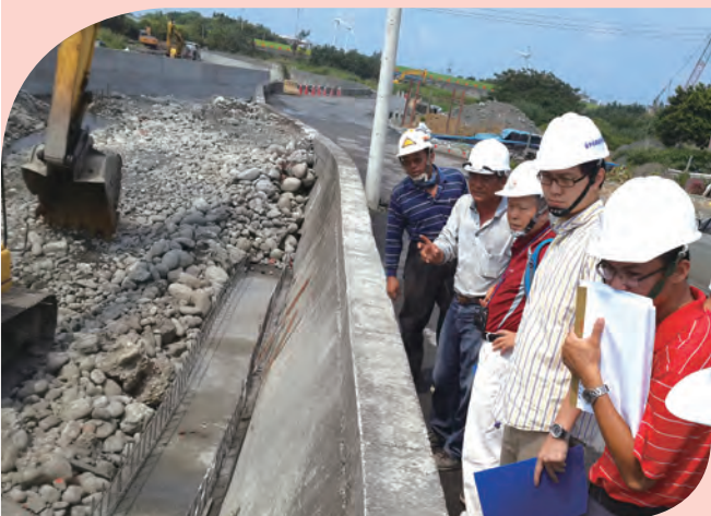
▲ 六股排水排水及灌溉溝渠改善工程督導。
