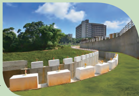
龍山路整建約176公尺長的排水溝。
