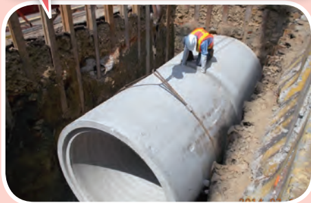
霧峰區吉峰路三期雨水下水道
