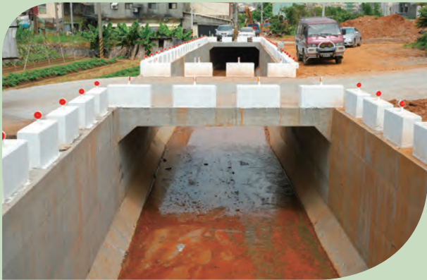
▲ 青年公園至福嘉巷加寬排水箱涵，增加排水效能。
