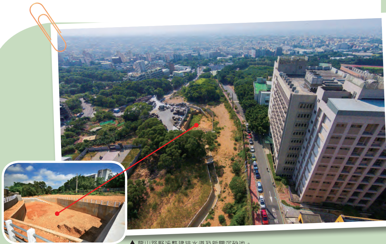
▲ 龍山路野溪整建排水道及新闢沉砂池。
