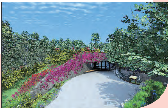
▼ 水滴水資源回收中心預計105年完工，將設置為地下化的生態水質中心。
