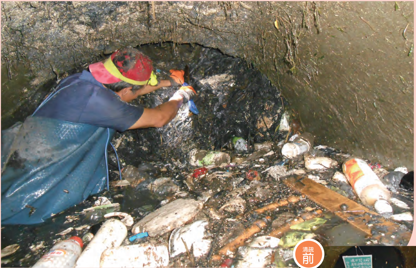
▲ 雨水下水道內塞滿了垃圾及廢棄物，請民眾愛惜河道，勿將垃圾傾倒在水溝或排水道。
