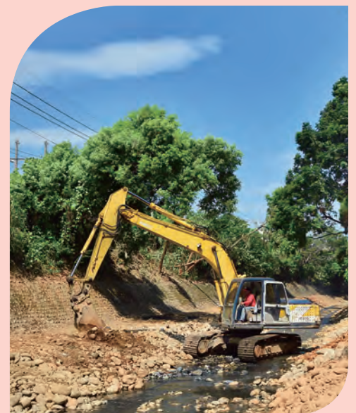
▲ 巡查人員通報可即時派工疏通，維持排水暢通。
