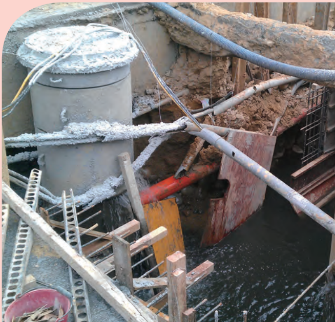
▲東區富榮街雨水下水道興建時，經過多次開會協調及現勘多達40次，才順利完成管線遷移。
