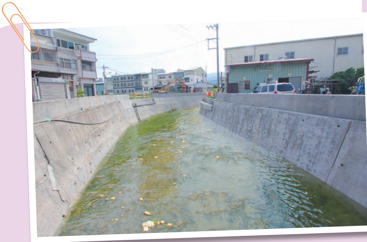
▲東村橋下游護岸拓寬增高改建。
