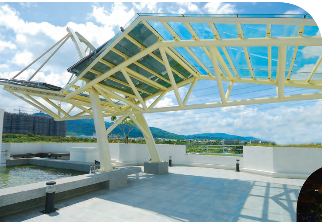
▲ 水資源回收中心內裝置隔熱玻璃及太陽能板重複利用能源。
