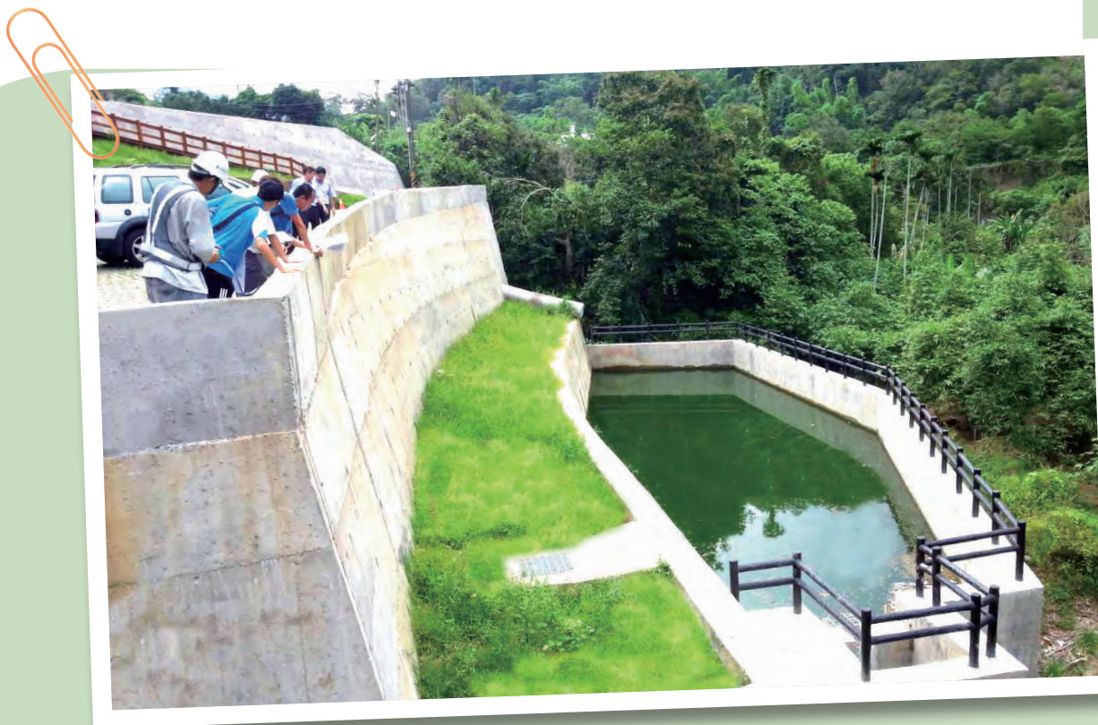
▲ 良好的滯洪沉砂池對坡地開發安全功不可沒(北屯區坡地建築開發申請)。
