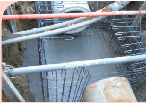
▲太平區中和街及東村8街施工期間曾遇管線阻擋，經管線協調會議後重新動工。
