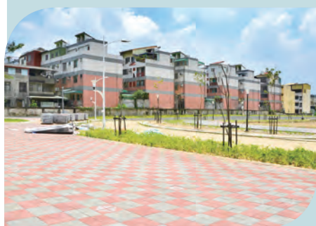
▲ 外圍的環園步道大致已鋪設完成，皆採用透水地磚。
