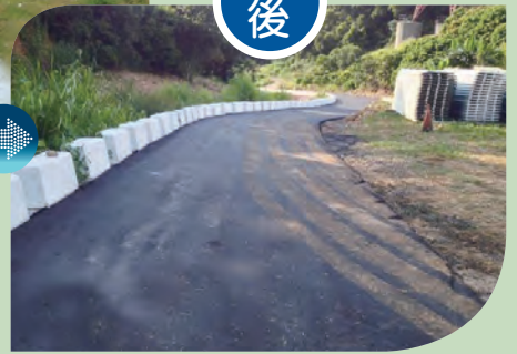
沙鹿區犁分里農路完工後。
