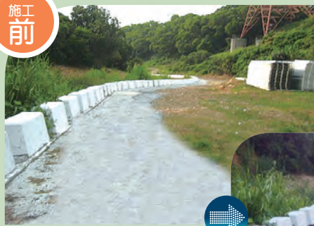
▲ 沙鹿區犁分里農路改善施工前。
