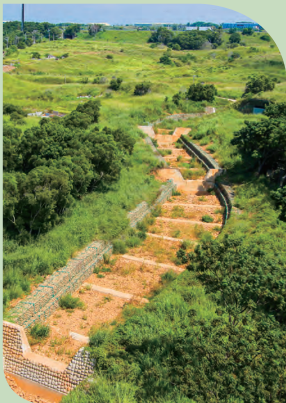
▲ 鰲峰山園內野溪水保設施已於103年完工。
