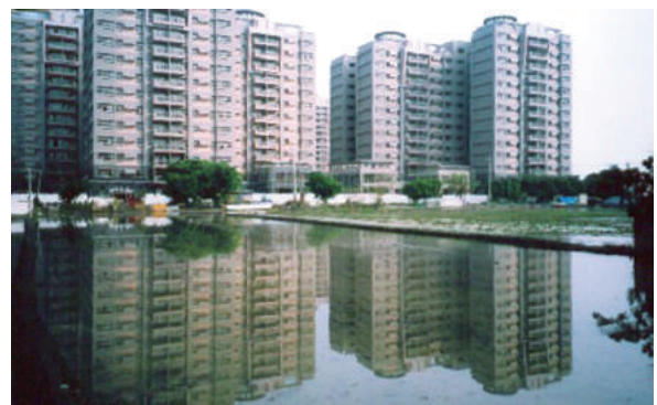
【圖 2-5-18】陽明新村、果貿一村改建竣工全貌（童長春提供）
