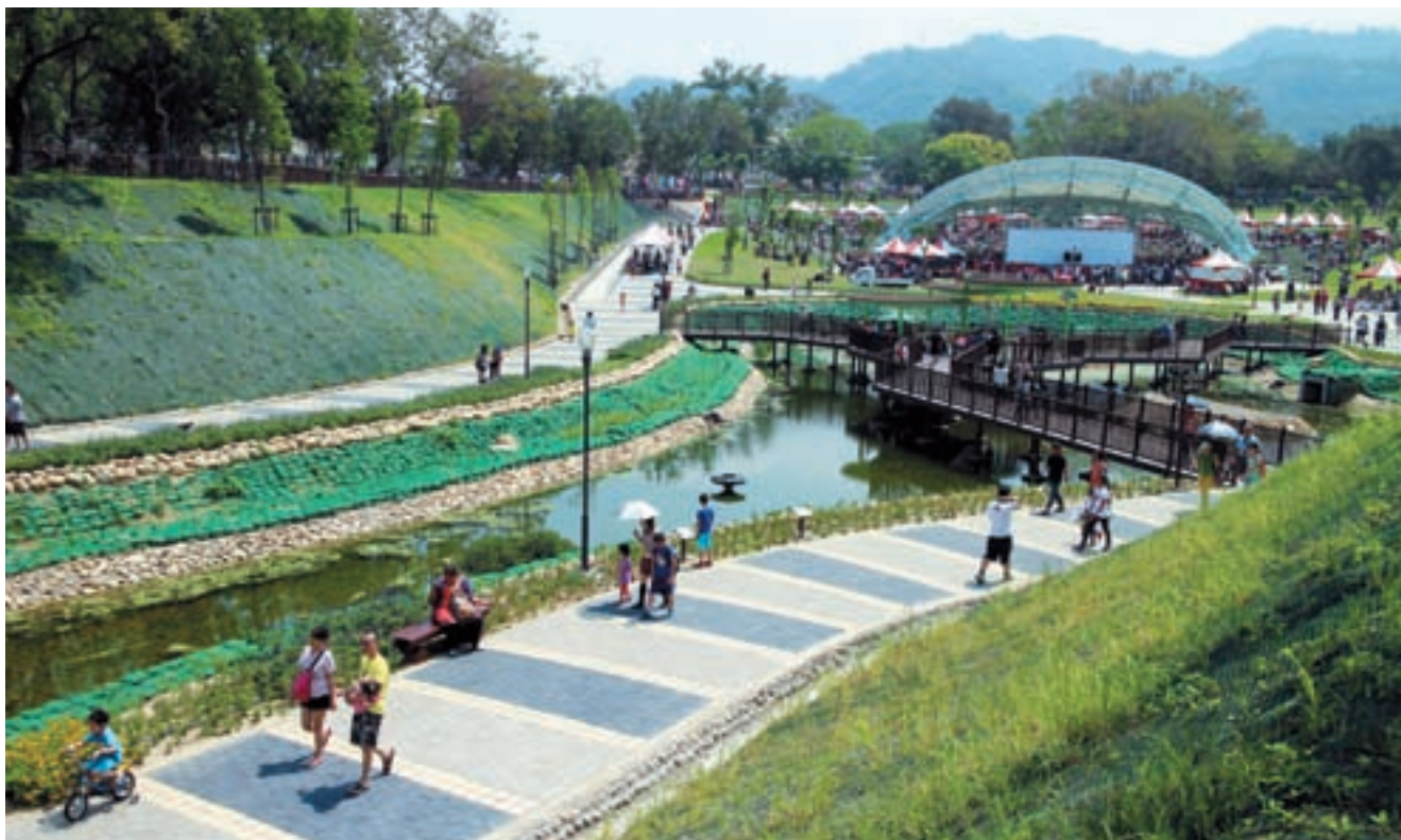
生態多功能滯洪池及大型戶外展演廣場讓公園兼具防洪及休憩功能。
