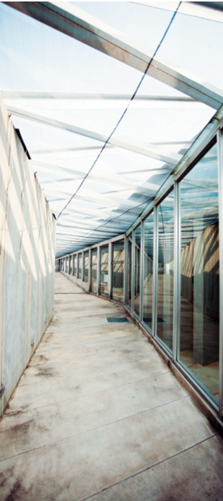
以鋼材、鋼索、預鑄預力水泥板等看似臨時卻構築性強的材料，搭建長條型的動線空間。
