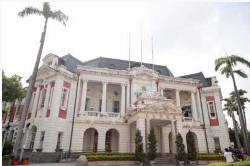
臺中州廳修復工程預計今年底完工
