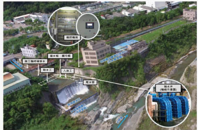
食水崙溪小水力發電廠規劃配置圖
