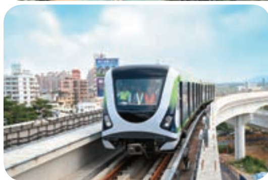
↑日前台中市政府進行捷運綠線試車情形。(台中市政府提供)
