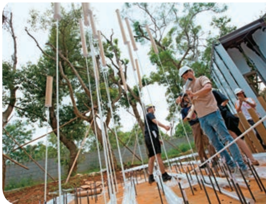
↓建築團隊採用立體模型製作軟體，將每一支紙管高度、位置都精準呈現。
