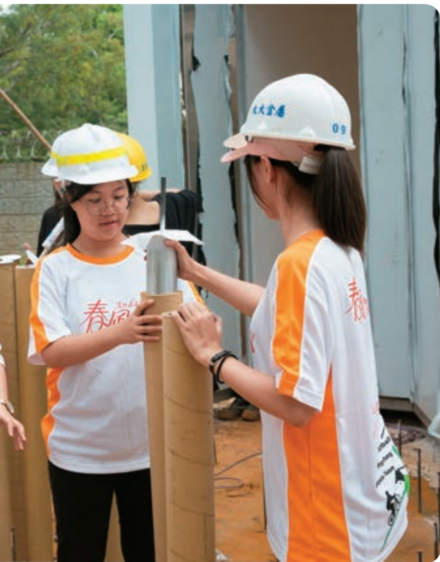
↓工程人員正緊鑼密鼓地為立體石虎模型排列一根根的再生紙管與鋼棒。
