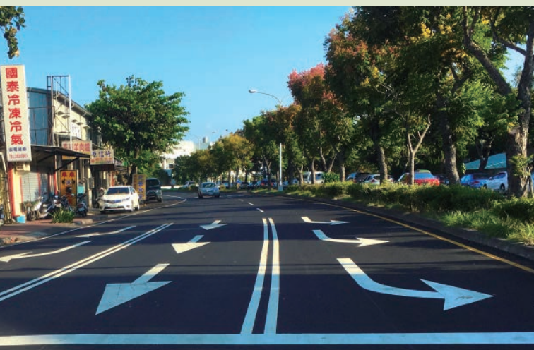
左圖：三環路緊鄰花博展區，為當地居民由市區通往后里或國道 4 號的重要銜接道路。
