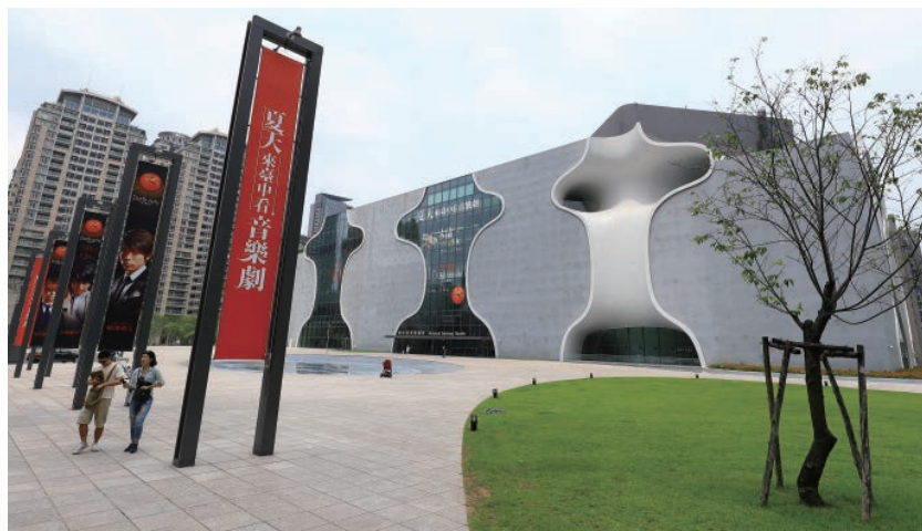
臺中國家歌劇院新建工程案參加「2018 全球卓越建設獎」，勇奪「公部門基礎建設／環境適意工程類首獎」。
