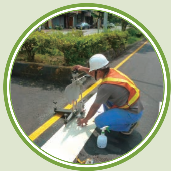
施工人員正在進行標線抗滑作業。
