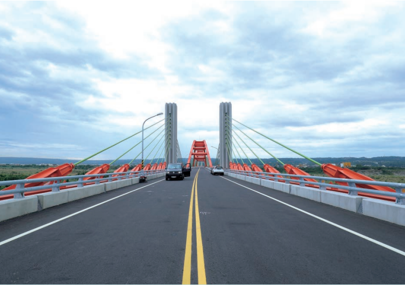
烏日區溪尾大橋完工通車後，可完善中彰生活圈。
