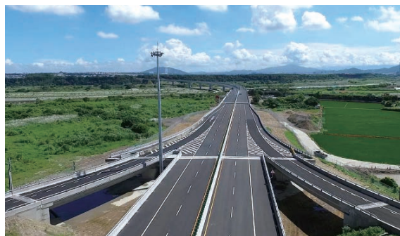
國道 4 號神岡交流道跨越大甲溪月眉西側南向聯絡道工程為臺中市政府推動 39 項道路建設之一，將有助於完善大臺中生活圈公路網，促進都市均衡發展。
