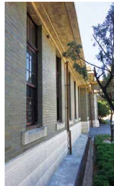
建築物牆立面
