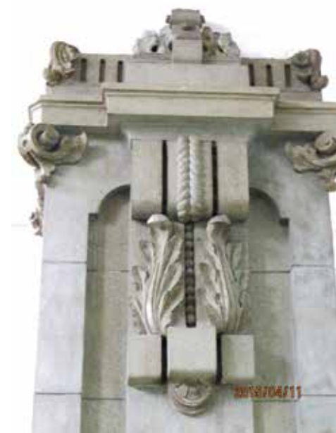
柱飾：在臺中火車站的大廳，可見柱頭以「開模印花」工法做成的浮雕裝飾。(朱書漢攝)
