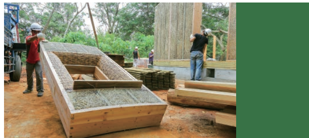
牆面結構採預製木構、稻桿捆牆體，圖為正在進行現場組裝。
