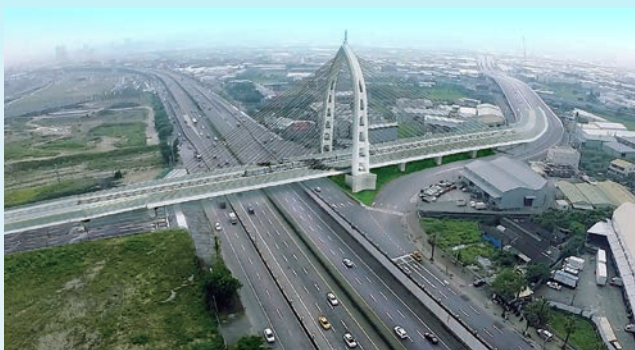
景觀斜張橋主塔採鋼構設計，為國內罕見橋梁工程。
