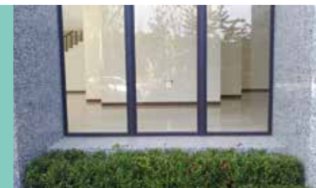
未設置開放空間告示牌
