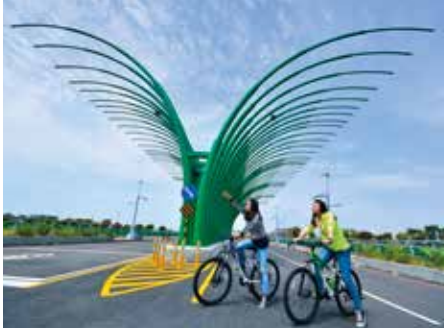
大坑清新橋 Qingxin Bridge
