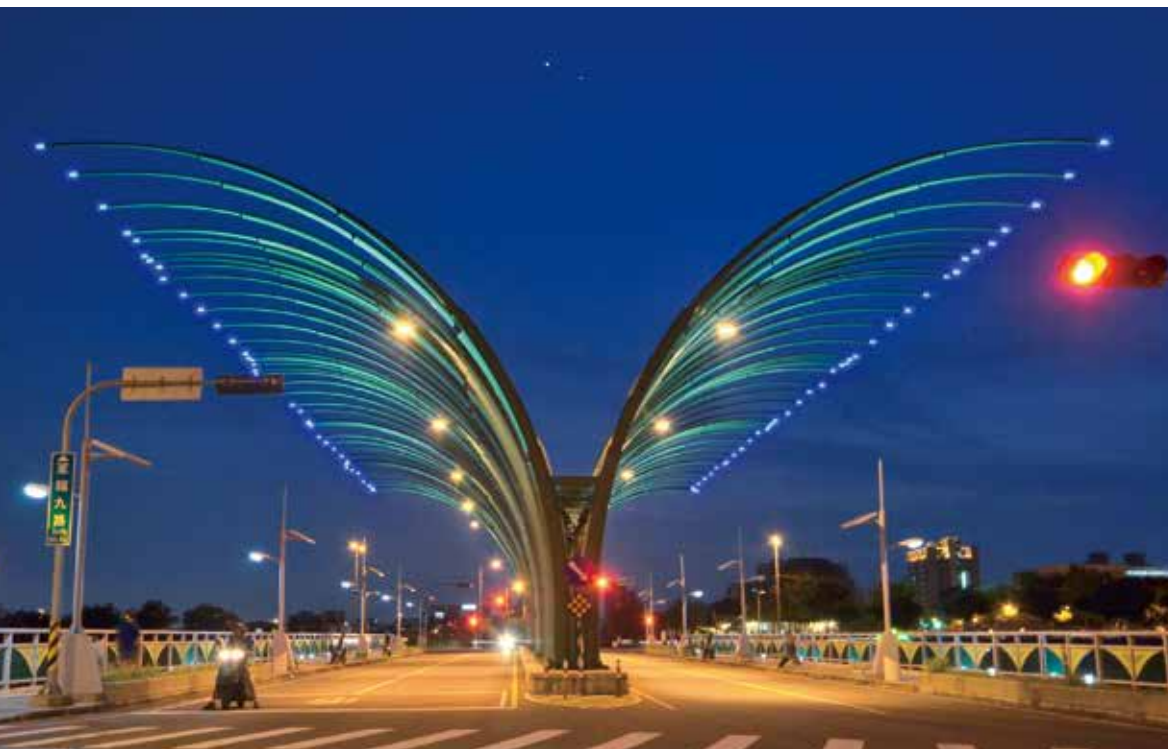
大坑清新橋 Qingxin Bridge
