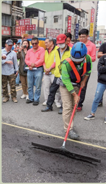
左圖 試辦工地施工，針對「防水、防滑、平整、耐磨」四大效果處理，有效提升路面使用年限。
