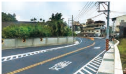
左圖 神岡區大豐路四段（主 2 號 15M）都市計畫道路工程，透過截彎取直暢通車流、提升行車安全。
