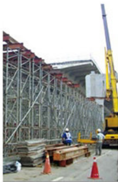
工程人員於現場階段交樑架
