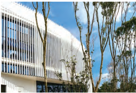
上圖 花舞館 A 館弧形空間外包覆金屬格柵，可從不同角度欣賞金屬格柵變化。
