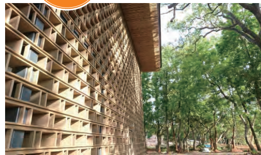
發現館使用再生塑化磚，堆疊成高拔的牆體。
