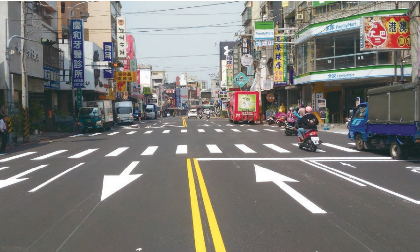
為改善商圈周邊道路品質，建設局已優先啟動福星路路平專案。
