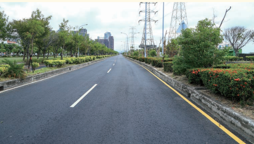
環河路路平完工，為史上首次全面大翻修。
