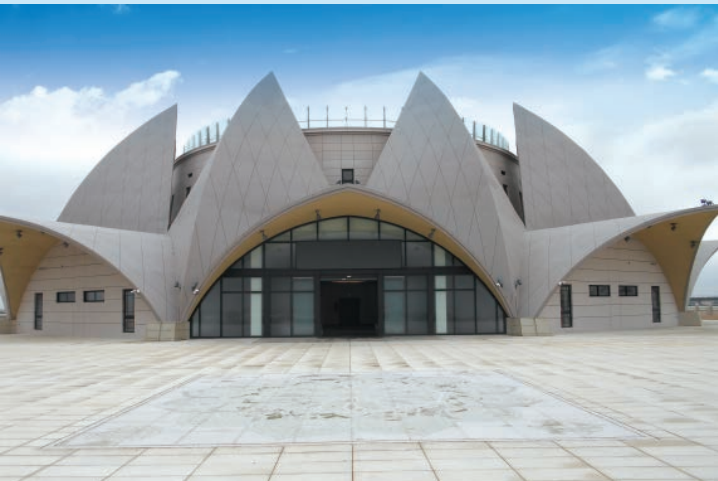
大安港媽祖主題園區總面積約 5.4 公頃，目前基座部分已竣工。
