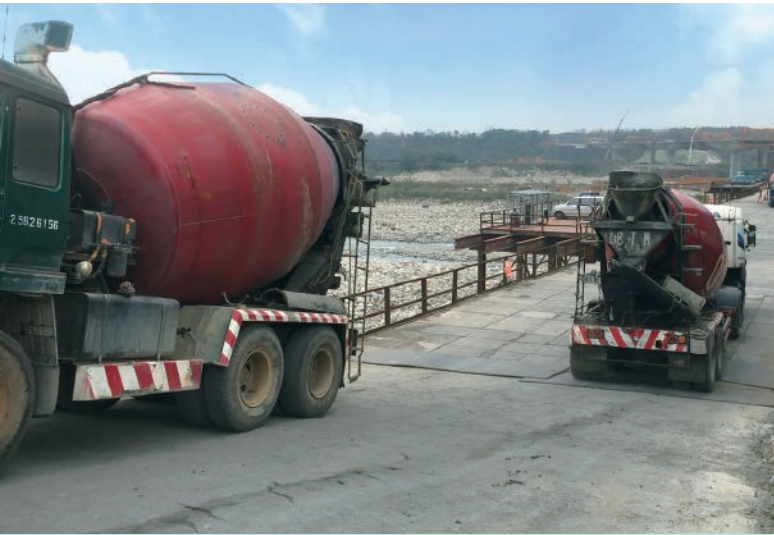
為對抗空汙，建設局全面加强工地防揚塵措施。
