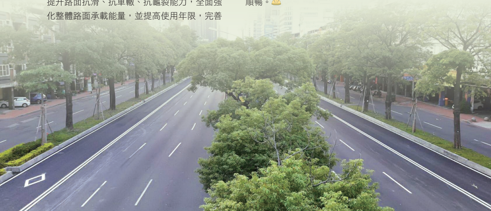
臺灣大道優化公車專用道，全面強化整體路面承載能量並提高使用年限。
