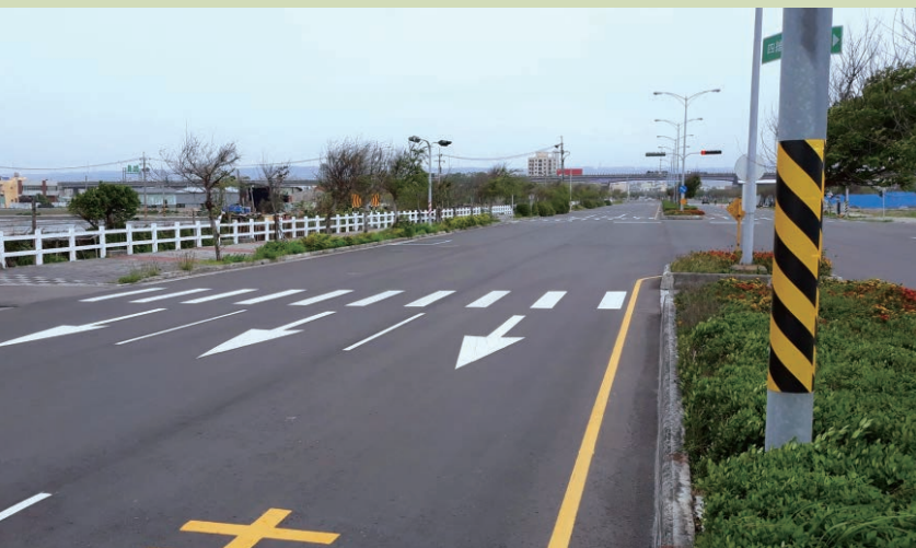
建設局持續推動海線路平工程，提升用路品質。
