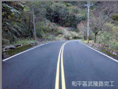
和平區武陵路施工
