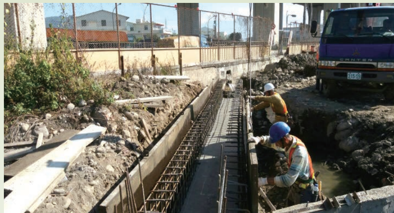
在兼顧工程品質及工地安全前提下，施工人員全力加速工程進度。
