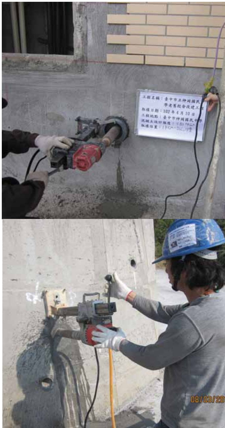
落實施工材料抽檢驗作業
