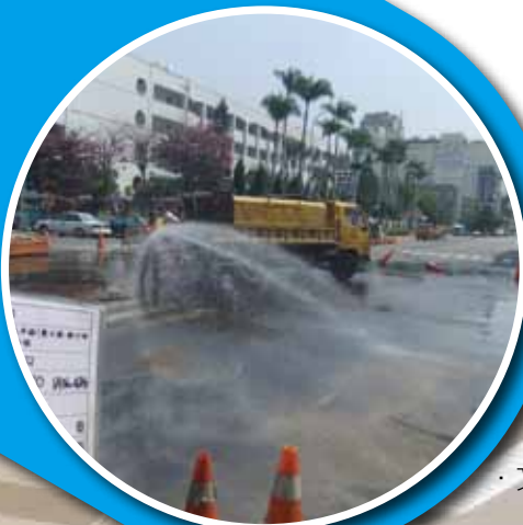
為施工現場清洗道路
