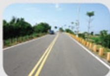
A. 舊式石塊護欄
