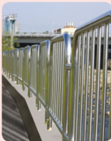
欄杆改善工程完成後，有助提升交通防護指數。
