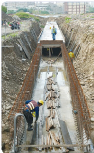
工人真正進行排水箱涵的模板組立。
