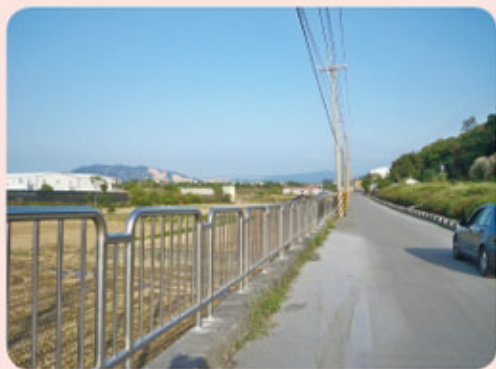
欄杆改善工程多位於農路邊與圳溝旁，加強用路人安全防護。
