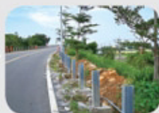
E. 埋入H型鋼立柱
