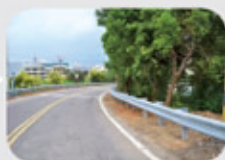
F. 鋼板護欄完工
