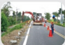
B. 拆除石塊護欄
