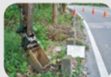
C. 工程機具挖方
