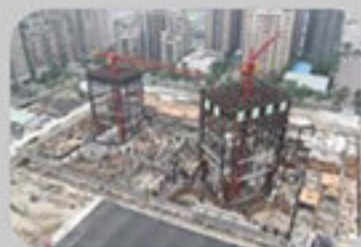
■99年12月 地下2樓結構體施工 (梁、柱、牆、板)、中 劇場轉塔鋼架工程
