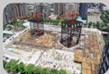
■100年6月 1樓樓板施工
