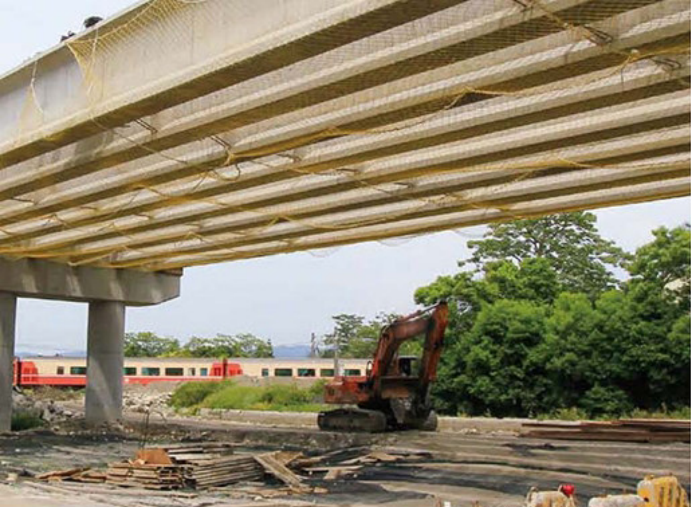
陸橋工程跨越產業鐵路，完工後即可帶來行的便利。
