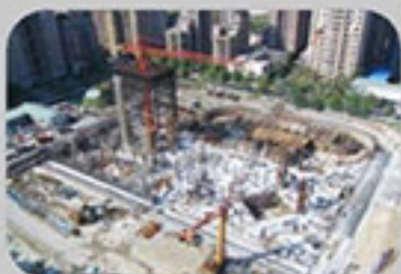
■99年12月 地下2樓結構體施工 (梁、柱、牆、板)、中 劇場轉塔鋼架工程
