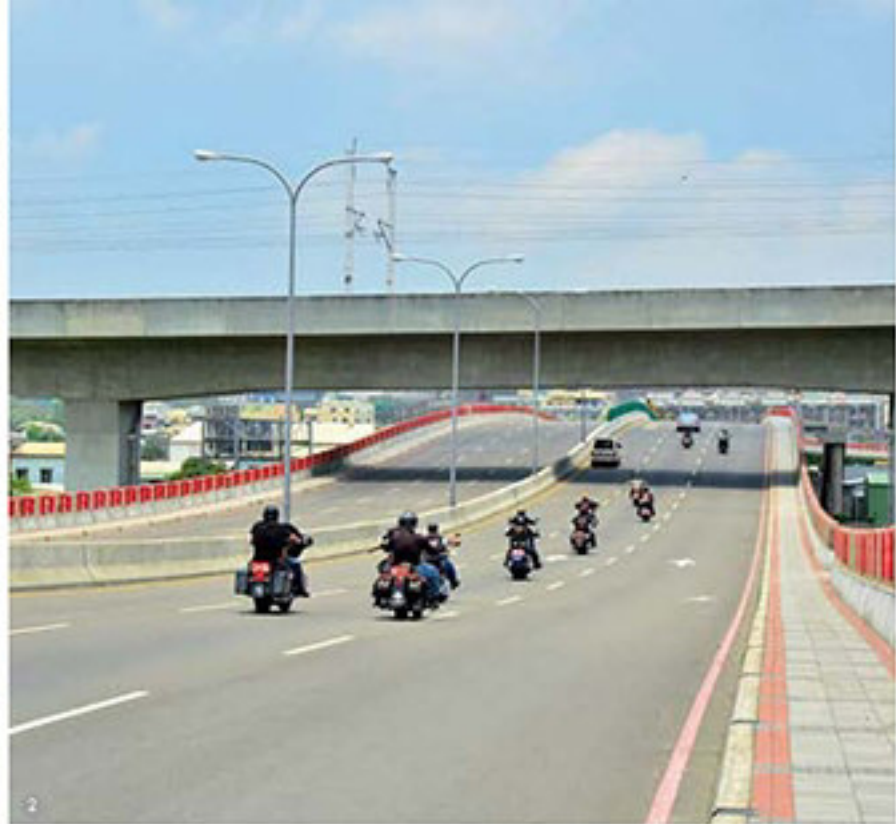
① 特三號道路與東西向交通動脈，有效舒緩南屯交流道壅堵。 ② 特三號道路巧妙適應地形變遷，形成波濤起伏的特殊景觀。
