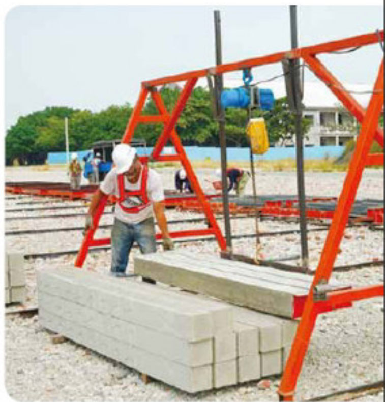
第一標工區正進行水泥柱製作，日後將預埋埋線網管機。
