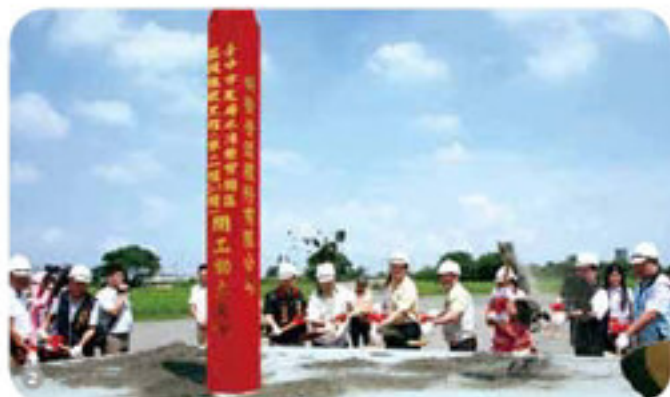
① 目前第一標工程進度已進入碎石級配鋪設工程，陸續將完成道路的鋪設。 ② 臺中市長（中）主持第二標、第3-1標開工動土典禮。
