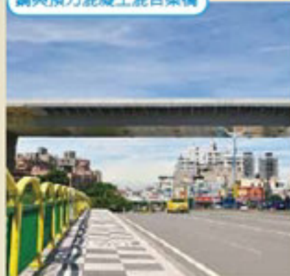
鋼與預力混凝土混合梁橋
