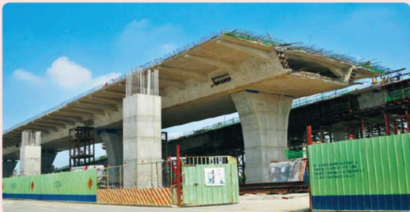
環中路高架工程正如火如荼的進行中。
