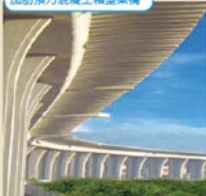
加肋預力混凝土箱型梁橋
