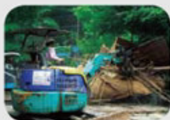
D. 進行拆除作業
