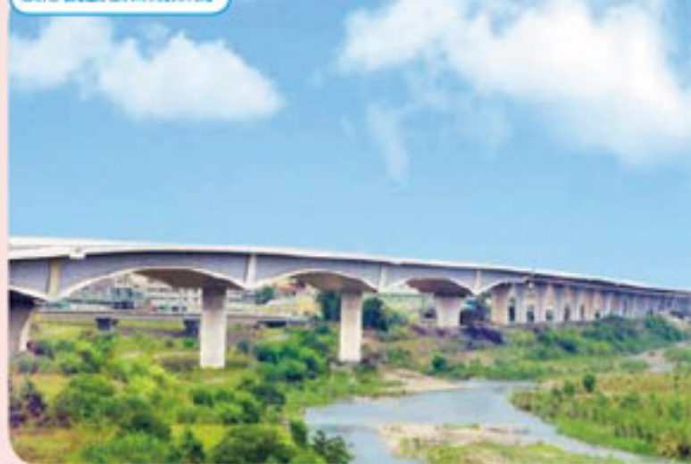
波形鋼腹板合成梁橋
