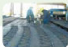
B. 鋼筋桁架 製作
