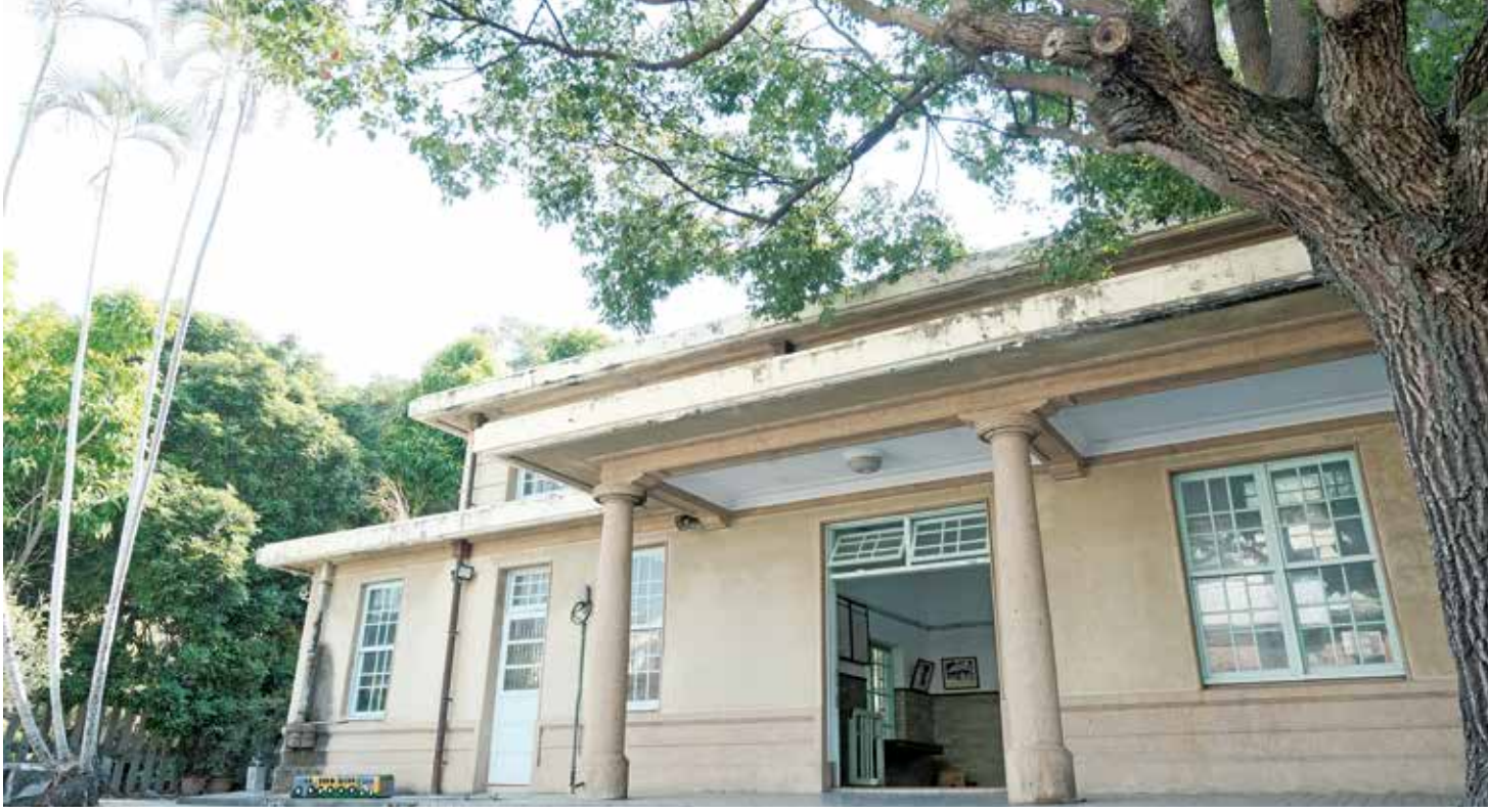
泰安站在地震後由木造改為 RC 混泥土結構
