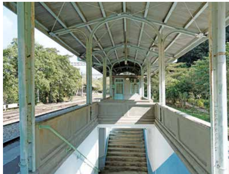
泰安站月臺上的棚架由廢棄軌道製成
