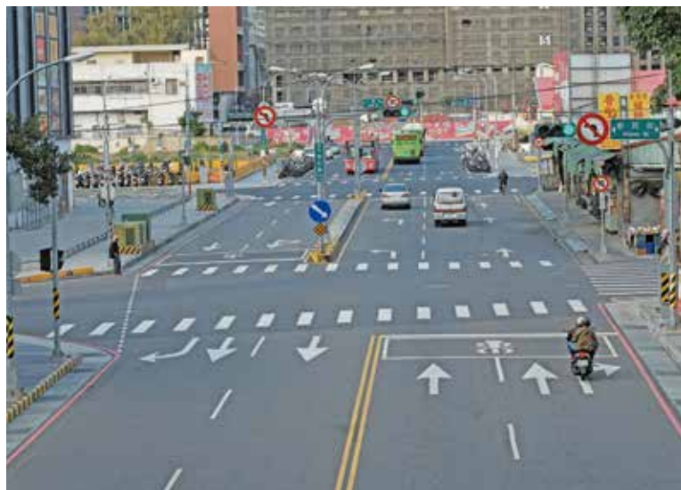
武德街已拓寬並改名為「大智北路」，隱沒在臺中發展的歷史中。
