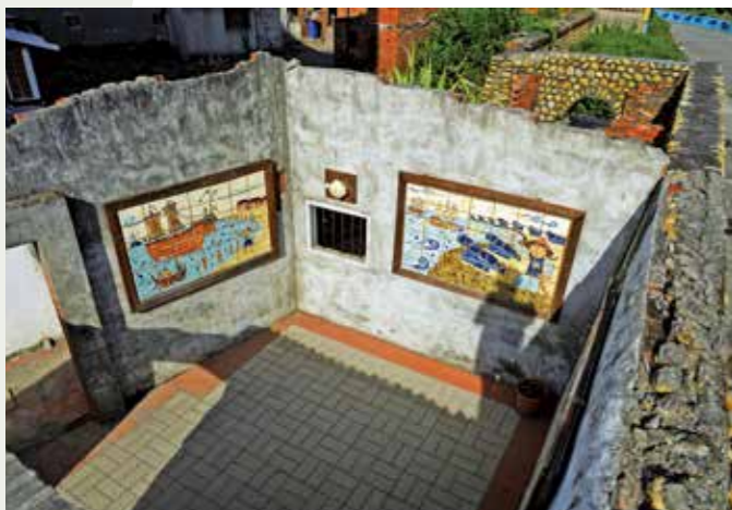
防砂牆內的大安港時光廊道
