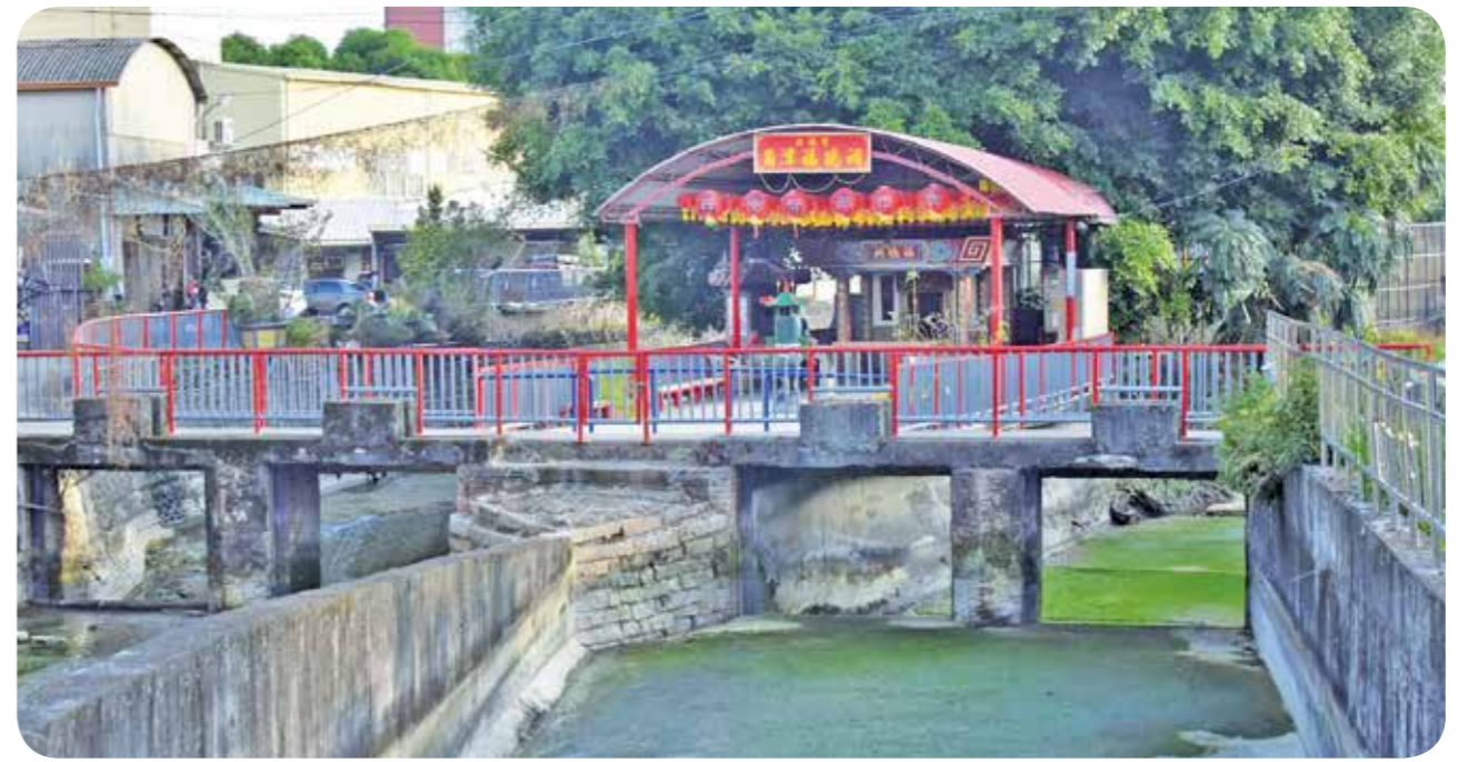
角潭福德祠坐落河道中間，有「水上土地公廟」之稱。
