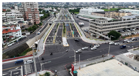
市政路延伸工業區一路至安和路段，已於去年5月率先通車。
