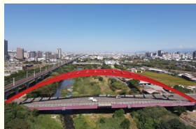
西屯區 虹揚橋
