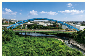
西屯區 福安橋
