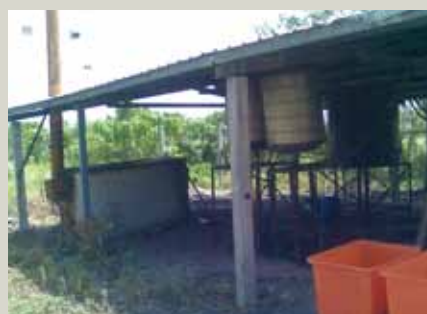
▲採用焚化方式-處理斃死畜禽之焚化爐
