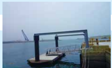
▲小型浮動碼頭完工後使用情形
