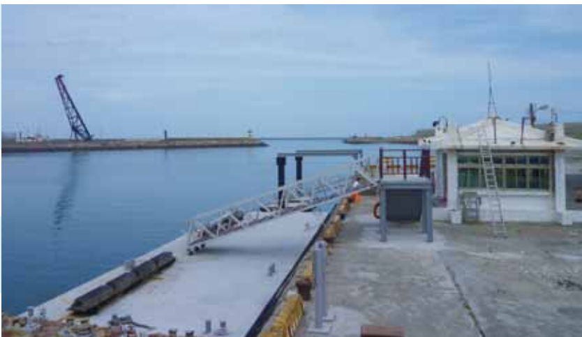
▲梧棲漁港安檢所前浮動碼頭完工後現況
