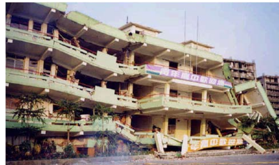
照片 2-4-2 大里市青年高中校舍倒塌情形
