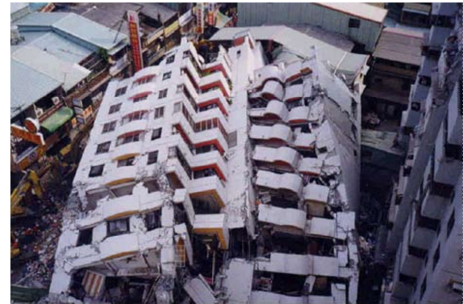
照片 2-4-1 大里市金巴黎大樓倒塌情形
