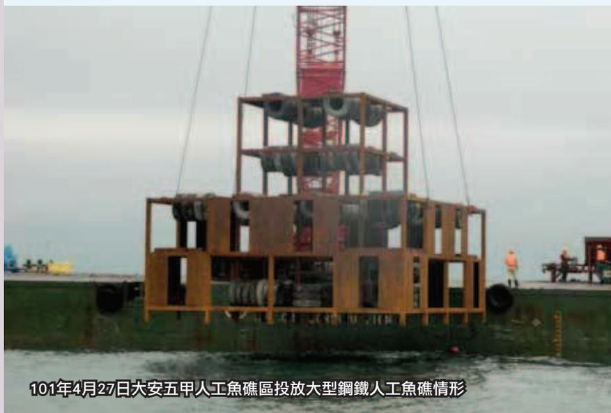
101年4月27日大安五甲人工魚礁區投放大型鋼鐵人工魚礁情形
