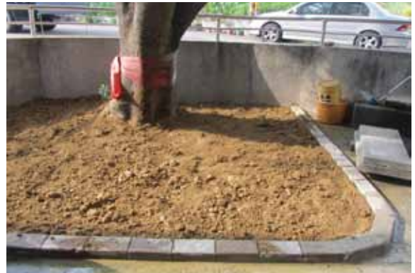
▲豐原區福德祠榕樹水泥鋪面刨除改善工作
